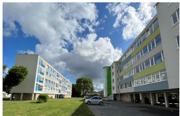
Projet Montfermeil Victor Hugo Après
